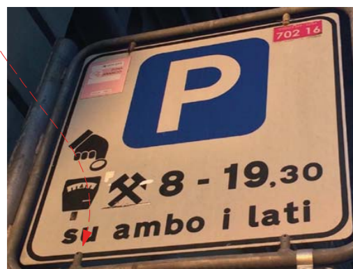
Esempio perni di ancoraggio del cartello bus alla cornice in acciaio inox
